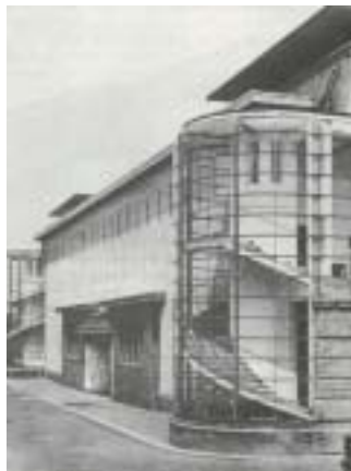
Edifício da Administração da Exposição, Colónia, 1914
