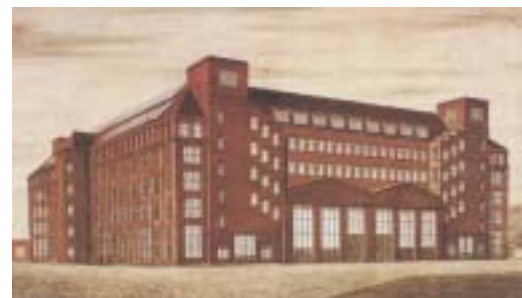
Fábrica de alta-tensão AEG, Berlim, 1909-10
